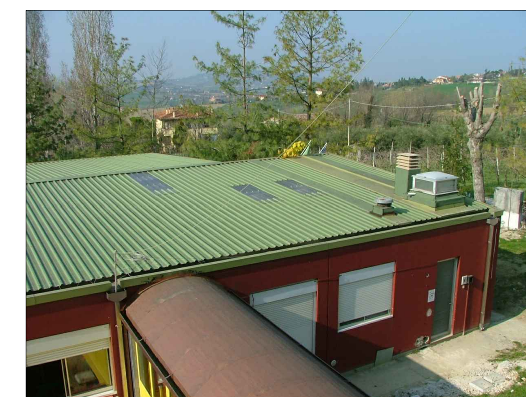
VISTA COPERTURA IN LAMIERA GRECATA
