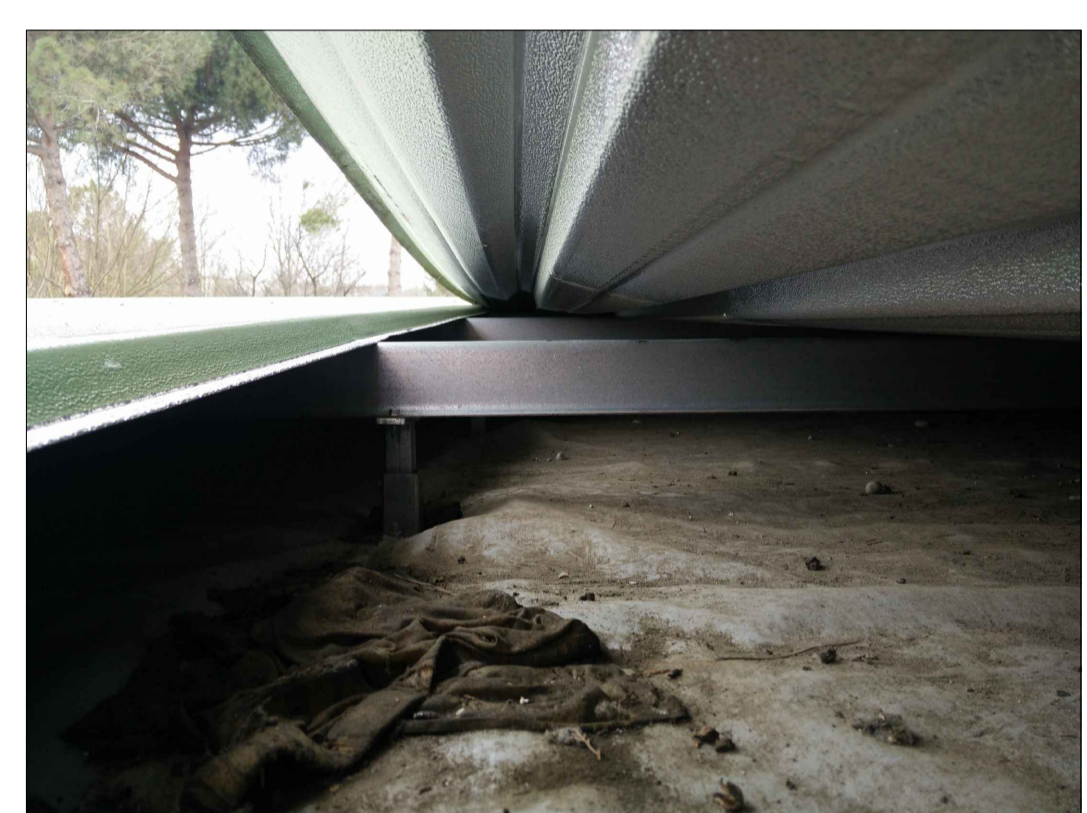
STRUTTURA METALLICA DI SOSTEGNO
