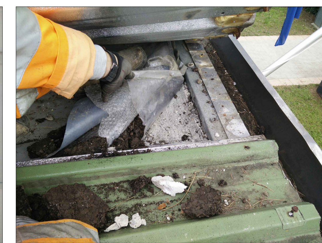
PACCHETTO COPERTURA ESISTENTE
