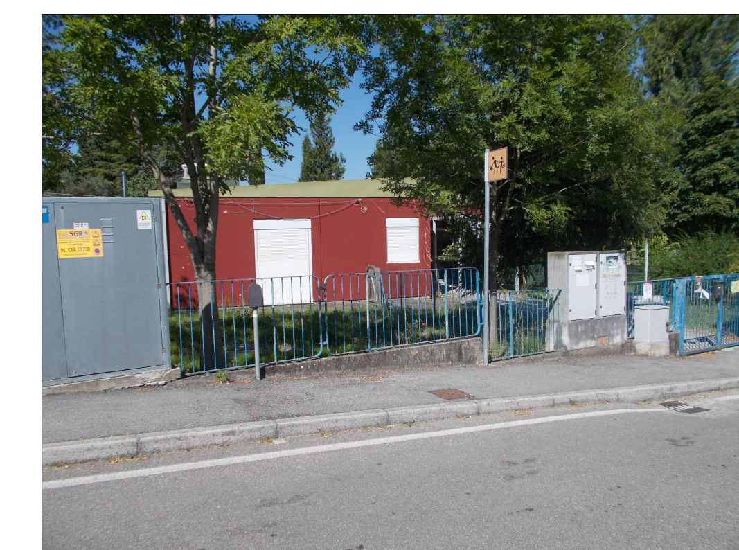
VISTA RECINZIONE LATO STRADA
